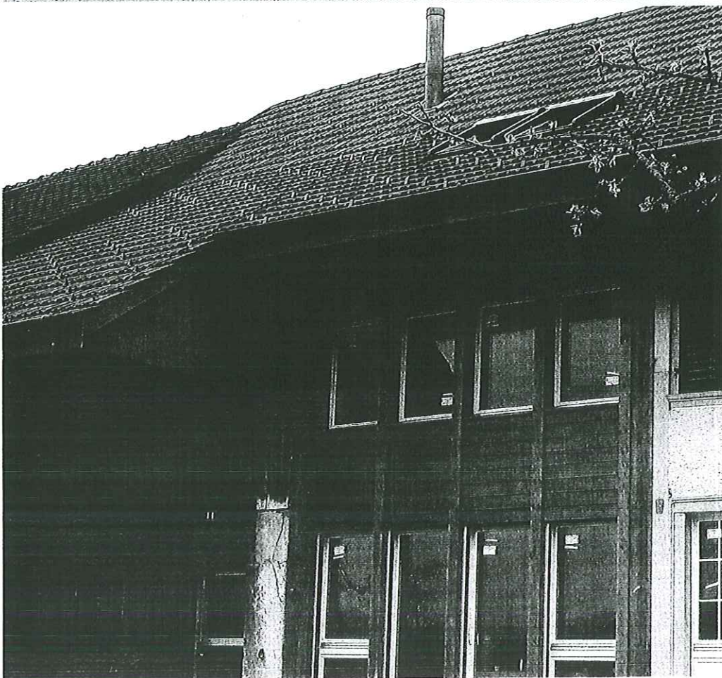
Ein Bauernhaus vor und nach dem Umbau: Ursprünglich ein Zweifamilienhaus, konnte es in ein Dreifamilienhaus umgebaut werden. Der Umbau hat sich für die Bauherrschaft trotz schlechter Bausubstanz gelohnt.
